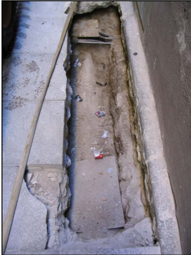
Foto 3. Vista de la rasa.
