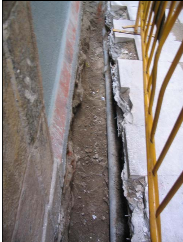
Foto 5. Detall dels serveis localitzats al subsòl.
