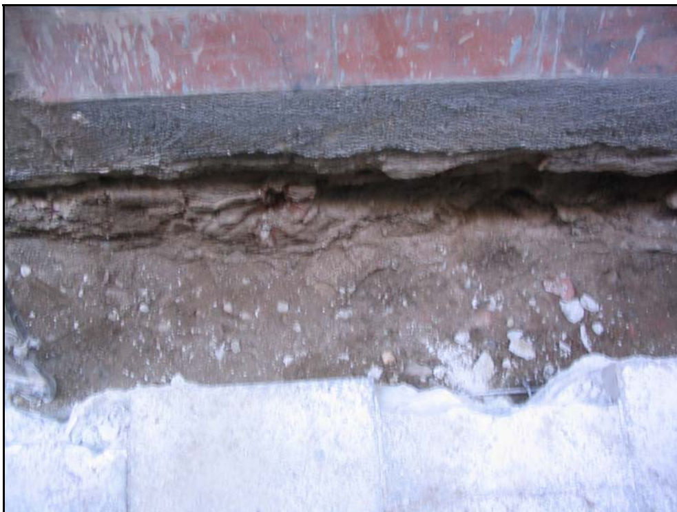
Foto 2. Vista de l'inici de la rasa, davant de l'estació transformadora de Fecsa.
