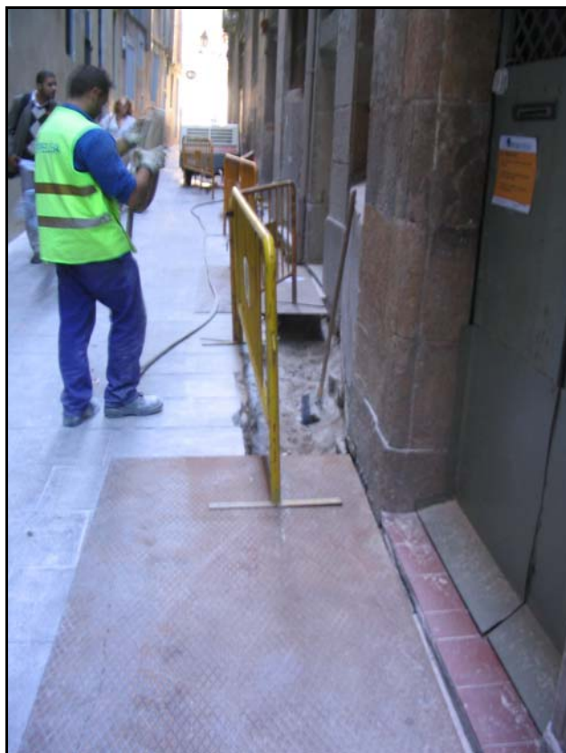
Foto 6. Vista del carrer d'en Roca amb la rasa oberta.
