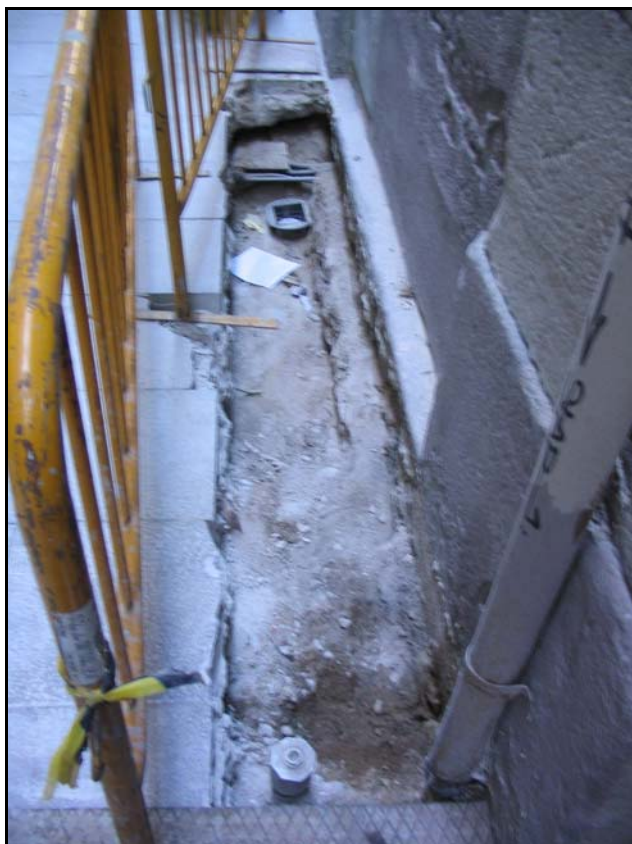
Foto 4. Vista de la rasa.
